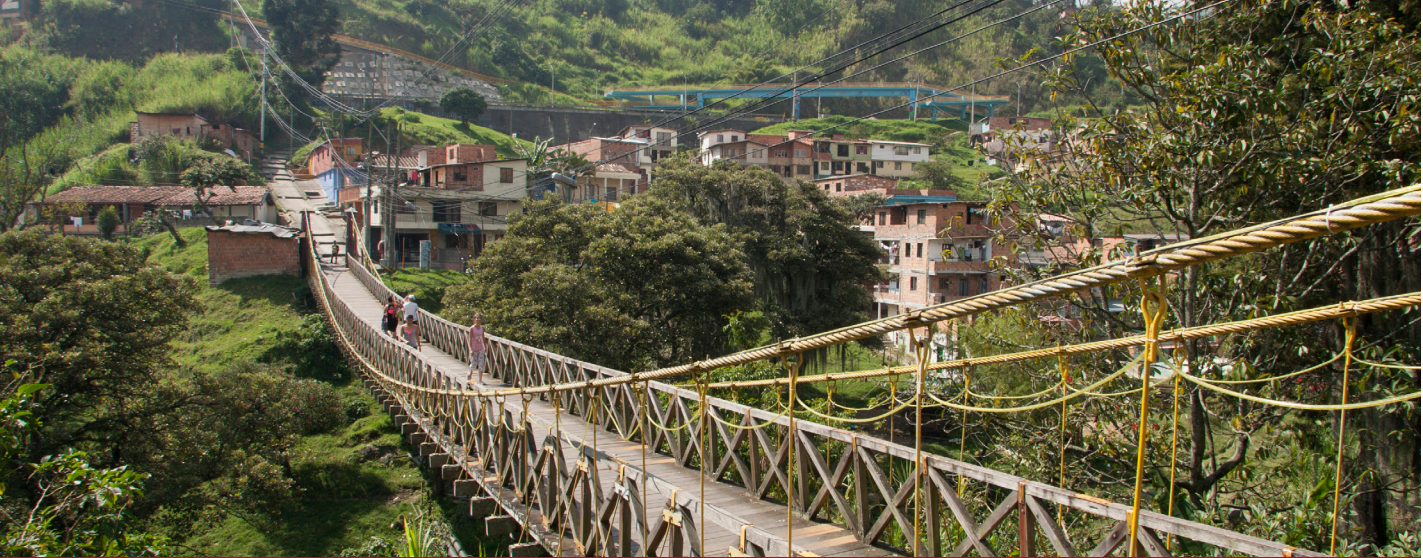
Puente colgante sobre la quebrada La Iguaná Vítaz
